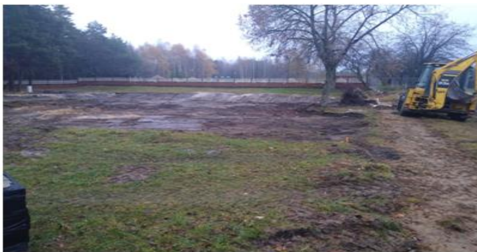
Zdjęcie: Rozpoczęcie prac
