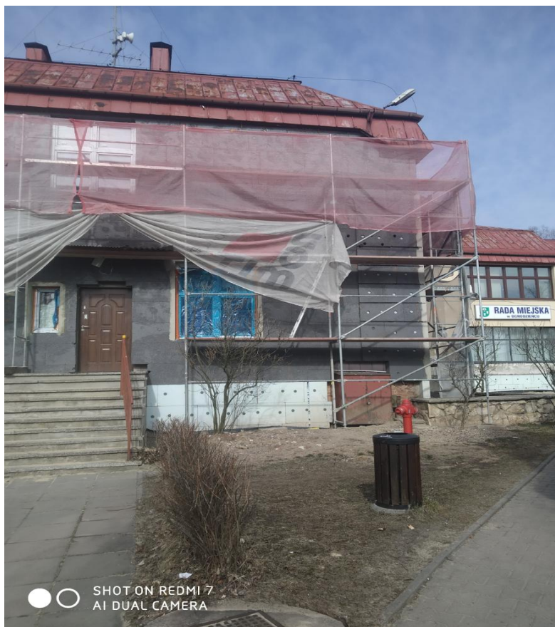
Zdjęcie: Prace przy termoizolacji - Trójbudynek
