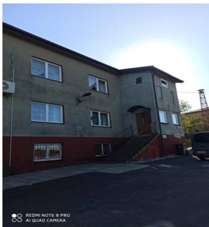
Zdjęcie: Front elewacji budynku remizy OSP Mokrus
