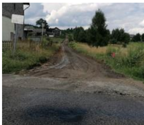
Stan przed inwestycją
