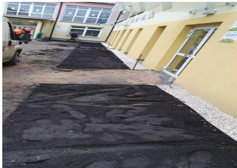
Zdjęcie: Prace wykończeniowe
