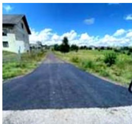
Stan po inwestycji
