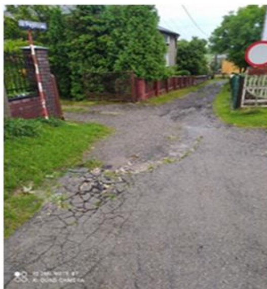
Zdjęcia: Uszkodzenie dróg gminnych w wyniku intensywnych opadów deszczu
