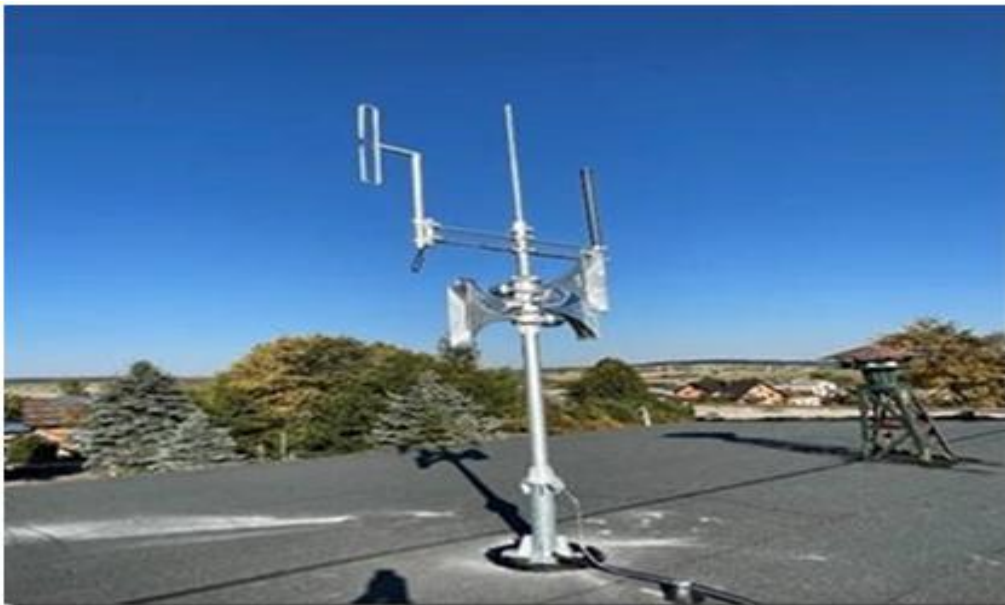
Zdjęcie: Syreny alarmowe wraz z antenami radiolinii OSP Giebło
