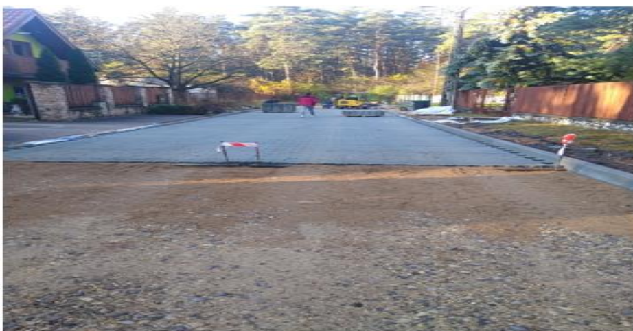
Zdjęcie: ul. Stowackiego – układanie nawierzchni z kostki brukowej
