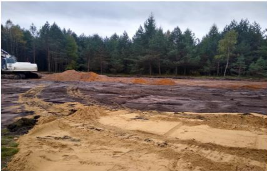
Zdjęcie: Tor pumptrack – korytowanie
