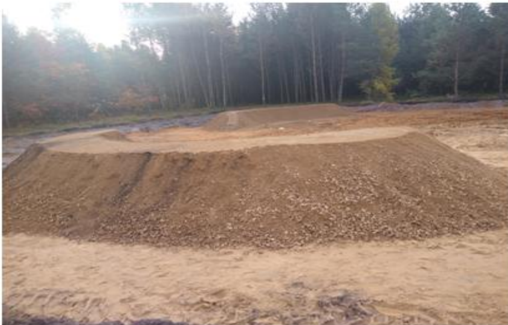
Zdjęcie: Tor pumptrack – podbudowa i profilowanie toru
