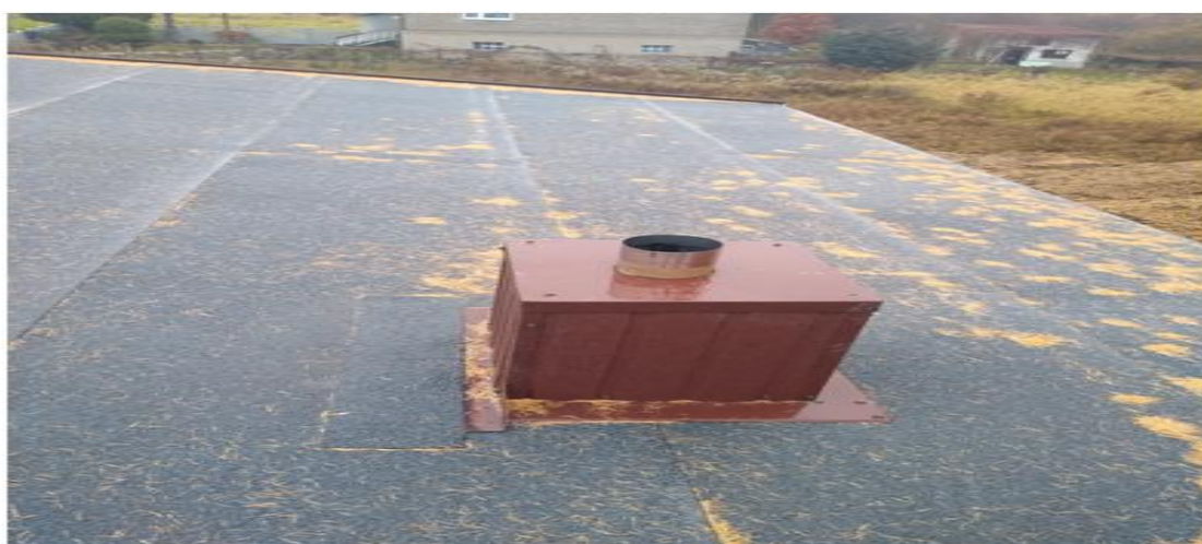
Zdjęcie: Dach Mickiewicza – pokrycie z papy termozgrzewalnej
