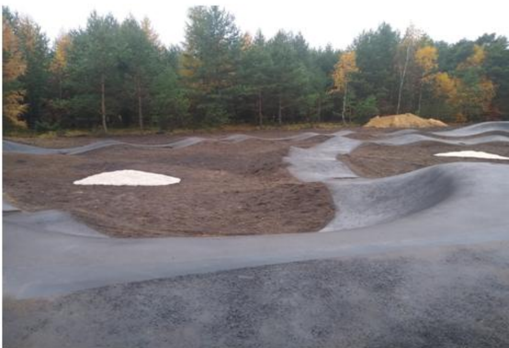
Zdjęcie: Tor pumptrack – nawierzchnia asfaltowa i odwodnienia
