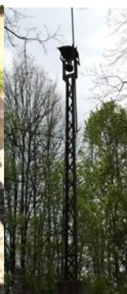
Stan po inwestycji
