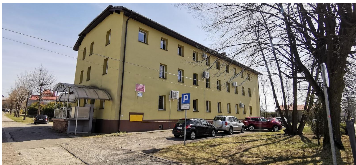
Zdjęcie: Budynek Przychodni
