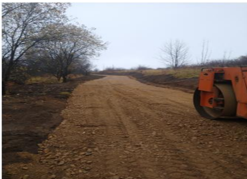
Zdjęcie: ul. Cmentarna – podbudowa
