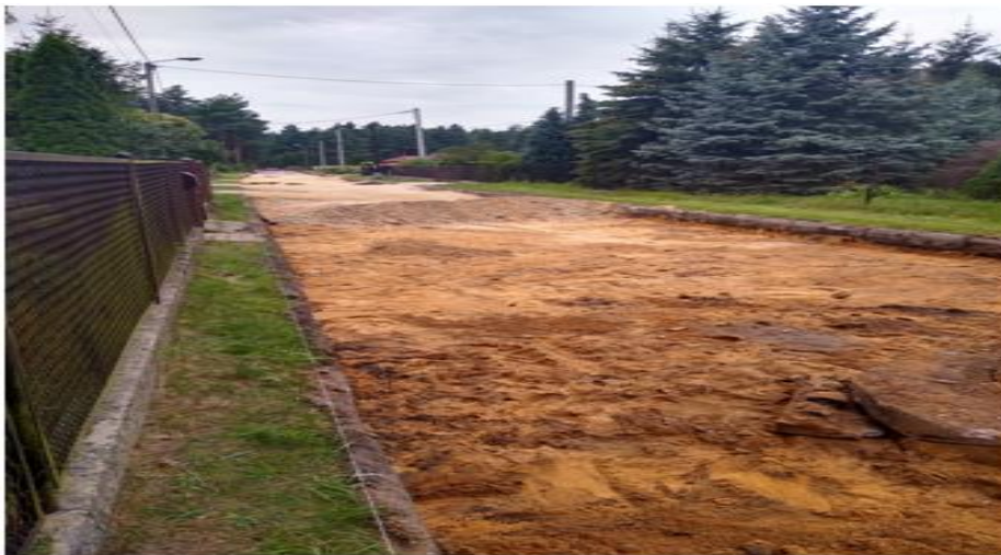
Zdjęcie: ul. Stowackiego – korytowanie i podbudowa
