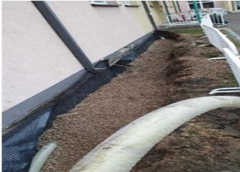
Zdjęcie: Układanie drenażu
