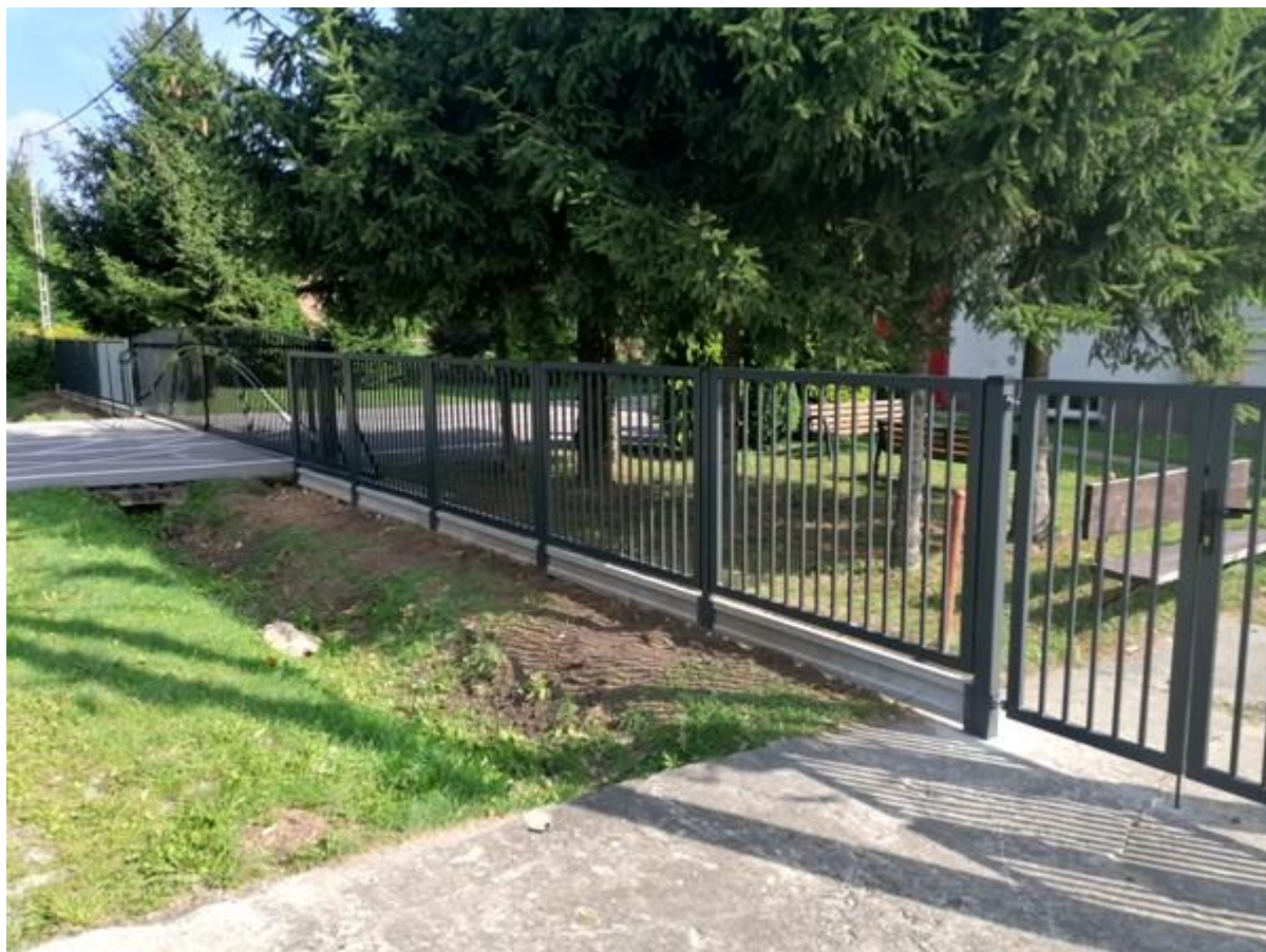
Stan po inwestycji
