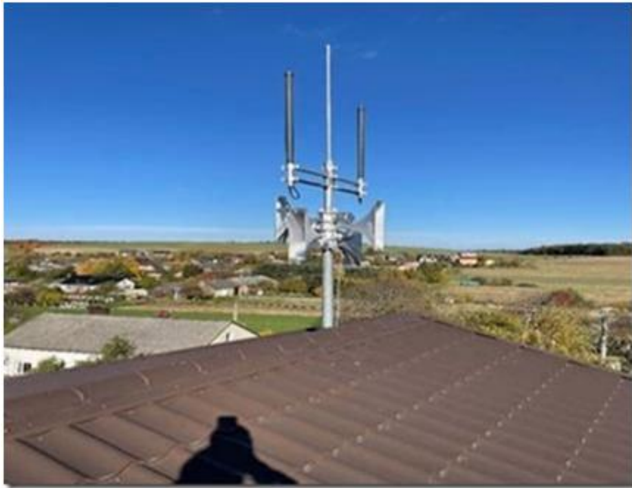
Zdjęcie: Syreny alarmowe wraz z antenami radiolinii OSP Mokrus
