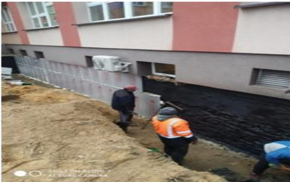
Zdjęcie: Izolacja pionowa przeciwwilgociowa i ciepła
