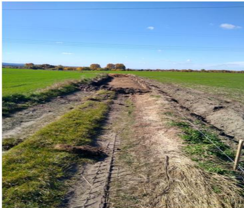
Zdjęcie: ul. Cmentarna – korytowanie
