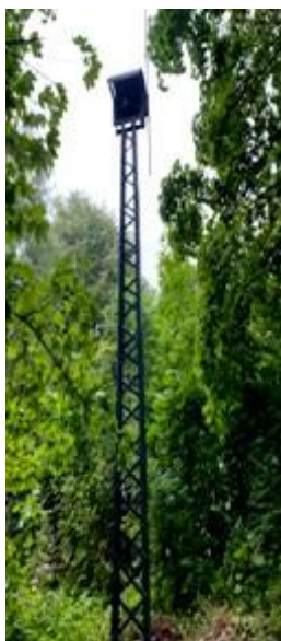
Stan przed inwestycją
