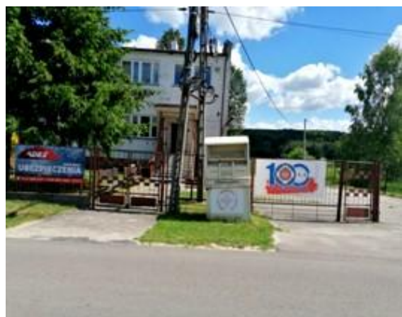
Stan przed inwestycją
