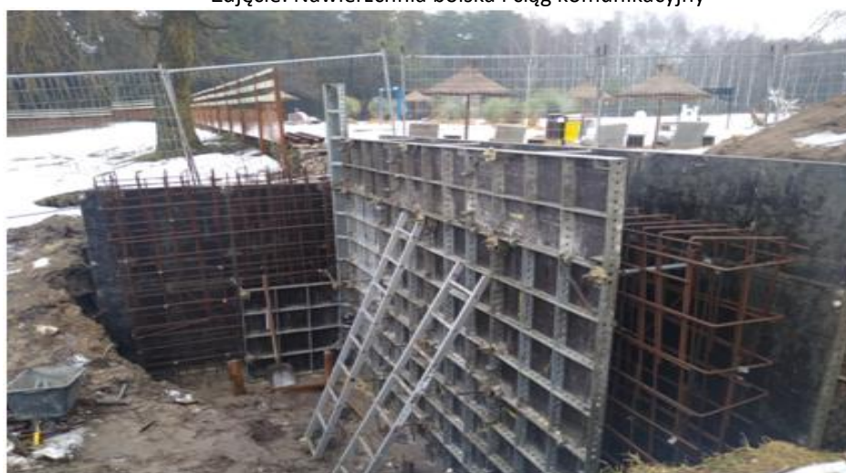
Zdjęcie: Zbrojenie ściany oporowej
