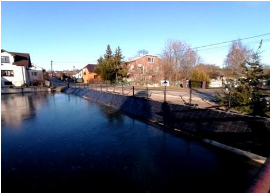
Stan po inwestycji
