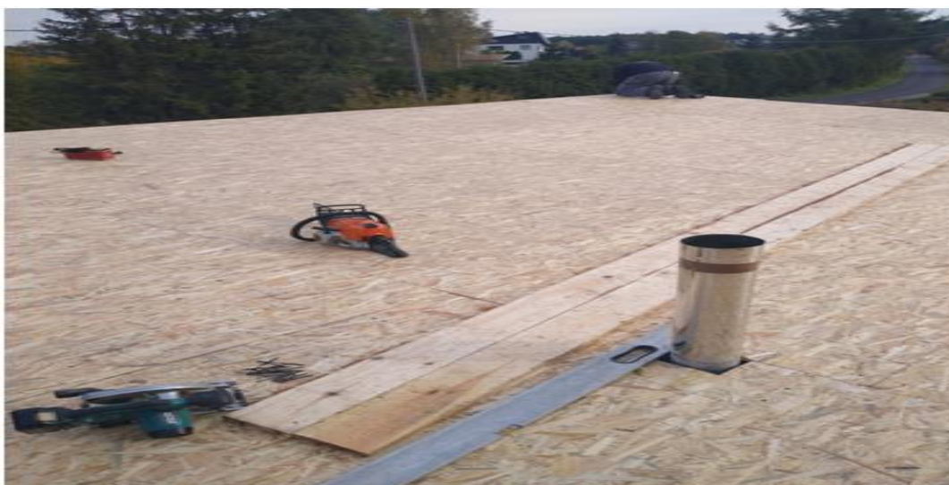
Zdjęcie: Dach Mickiewicza – płyty OSB
