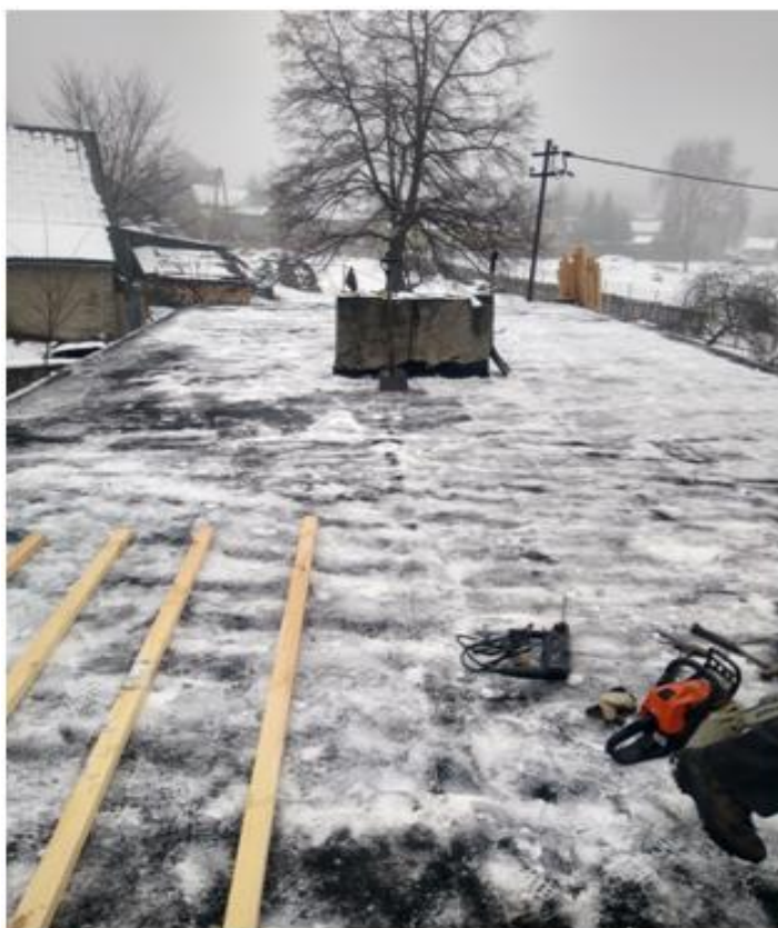
Zdjęcie: Układanie łąt
