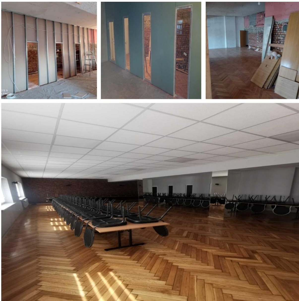
Zdjęcie: Sala OSP przed i po remoncie
