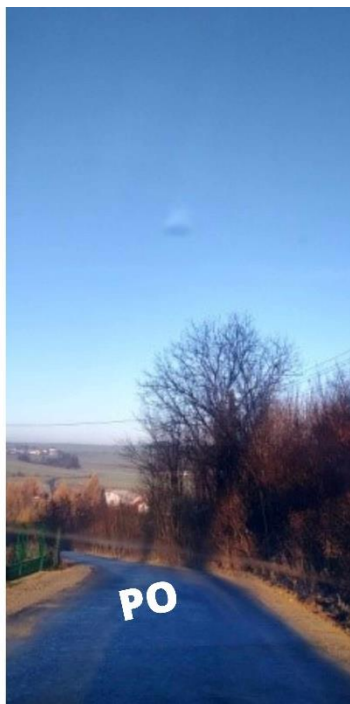
Zdjęcie: Przebudowa ul. Folwarcznej w Gulzowie
