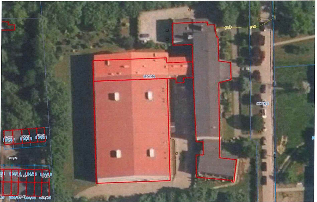
Zdjęcie satelitarne lokalizacji instalacji
