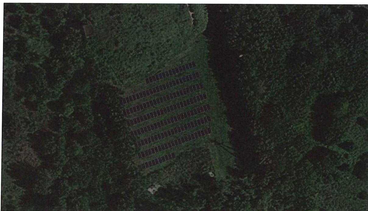
Zdjęcie satelitarne terenu instalacji wraz z pogładowym rozmieszczeniem modułów
