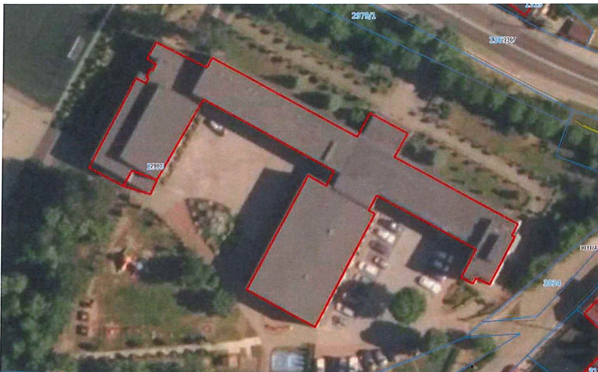
Zdjęcie satelitarne lokalizacji instalacji
