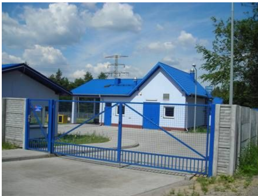
Fot. 14. Oczyszczalnia ścieków w Ogrodziencu
