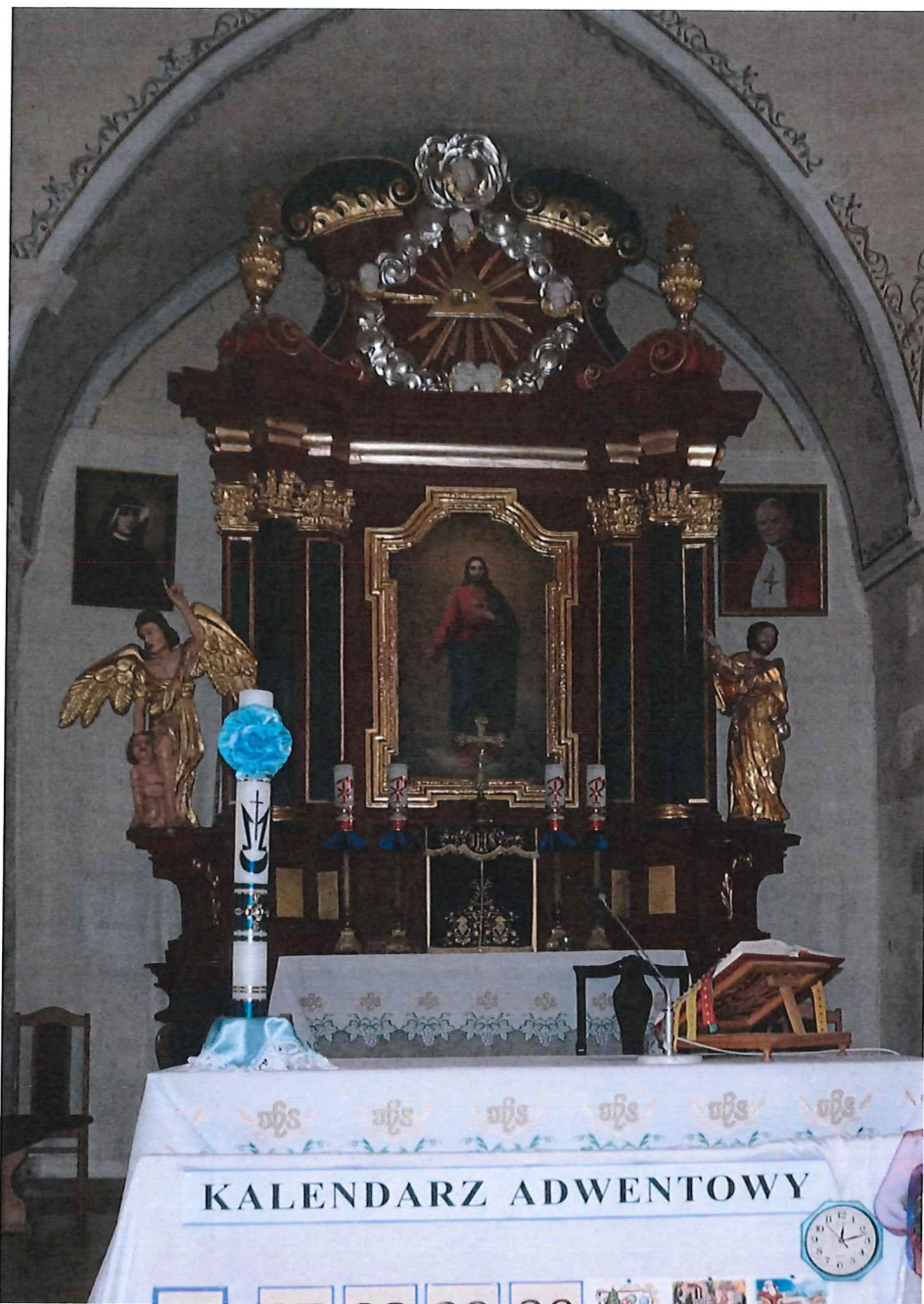
Fot. 2 I Gieblo, kościół św. Jakuba St. Apostoła. Stan zachowania obiektu przed konserwacją w 2017 roku. Widoczny ogólny stan zachowania obiektu oraz nieudolna rekonstrukcja figury Anioła autorstwa lokalnego artysty.
