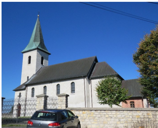
Ryc. 7 Kościół w Gieble, fot. I. Solisz
