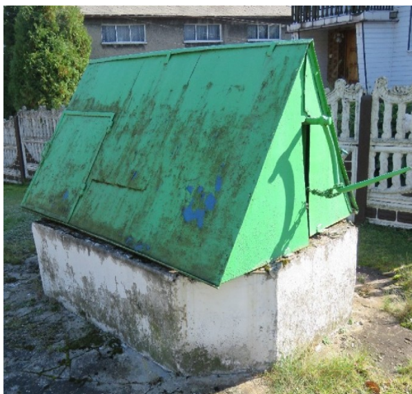
Ryczów, studnia przy ul. Grochowieckiej, fot. I. Solisz
