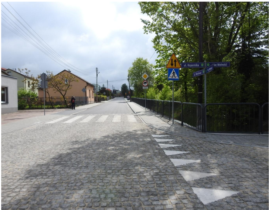
ul. Mostowa po przebudowie
