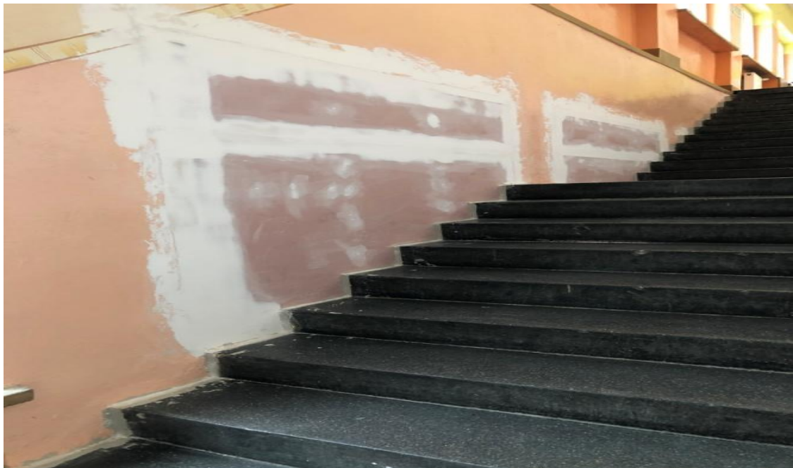
Stan przed remontem
