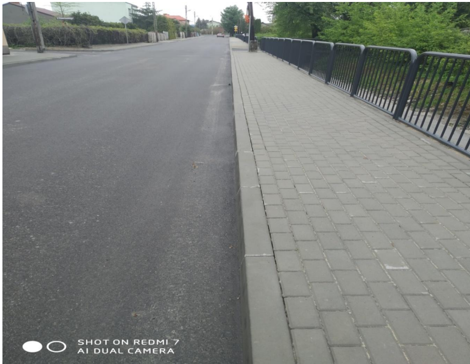
ul. Mostowa po przebudowie
