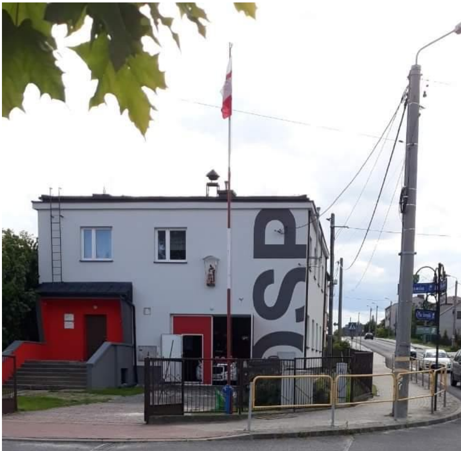
Remiza OSP Podzamcze w której zainstalowano nowy system ostrzegania i alarmowania
