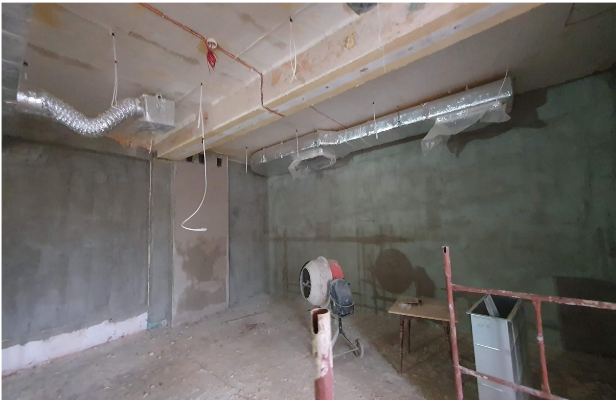
Stan w trakcie remontu
