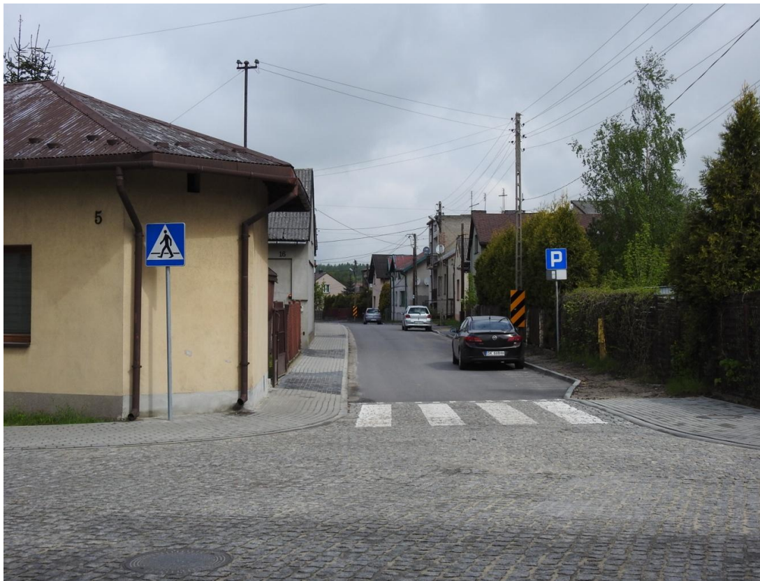
ul. Kopernika po przebudowie
