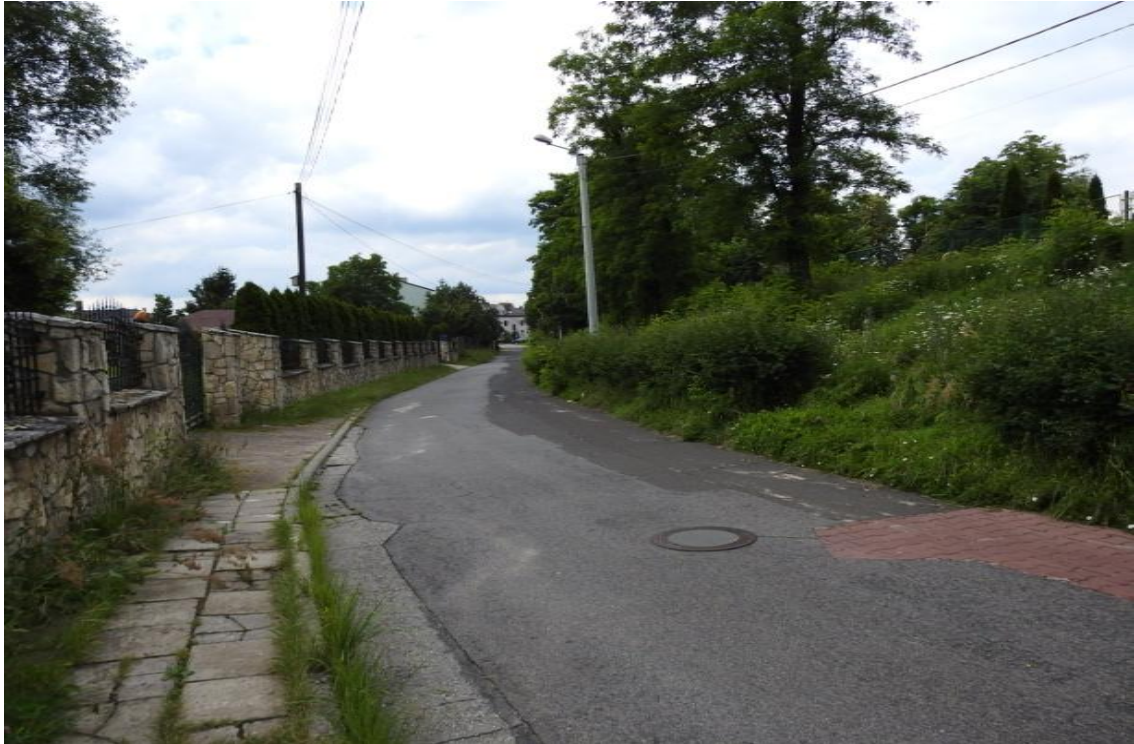
ul. Szkolna – przed przebudową
