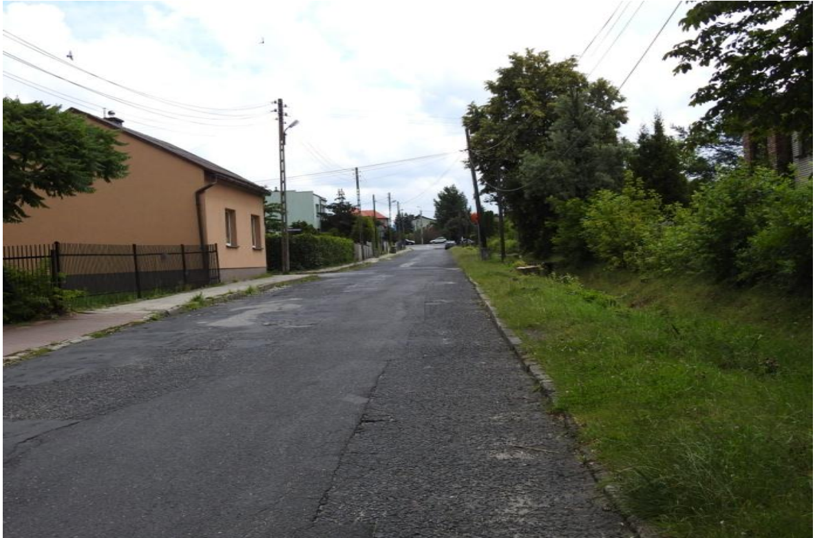
ul. Mostowa przed przebudową
