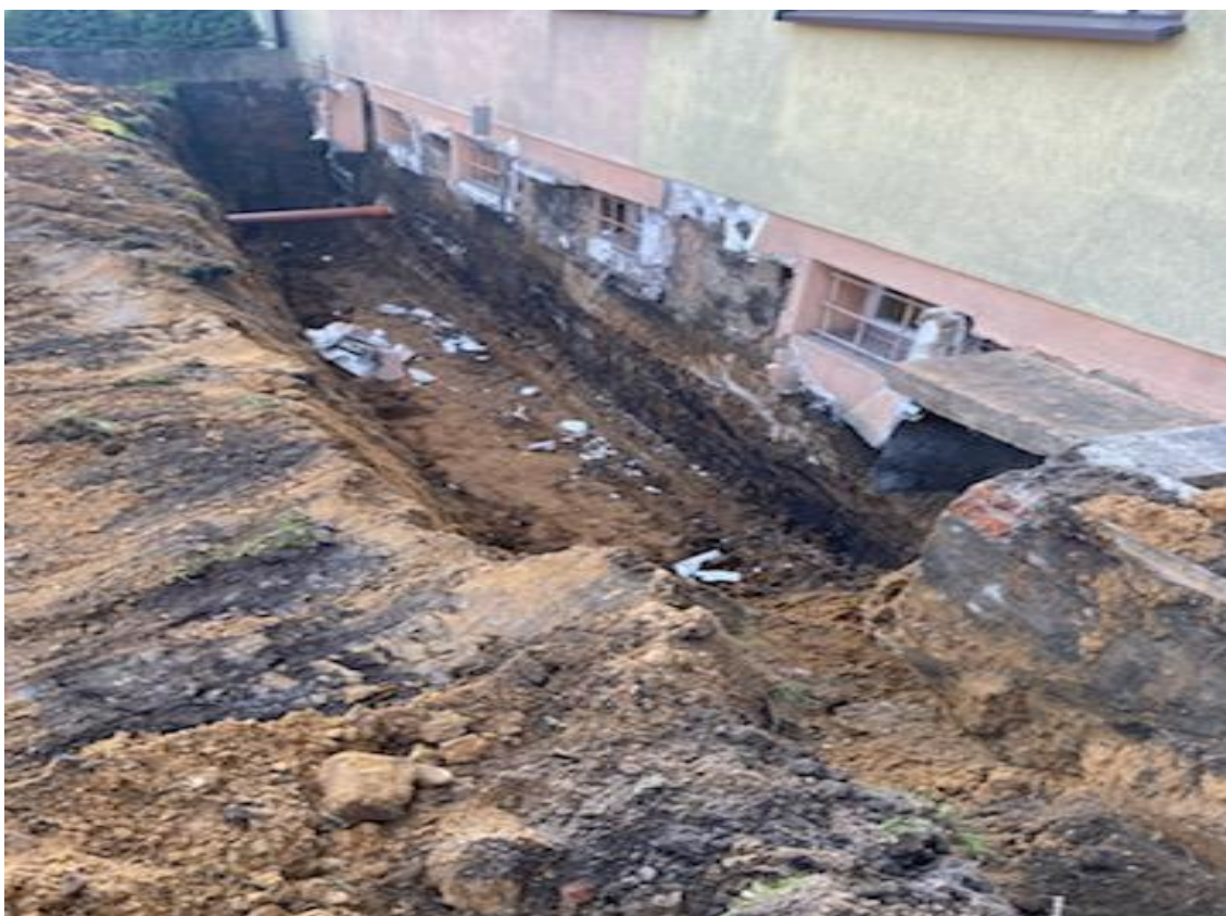
Stan przed wykonaniem izolacji fundamentów
