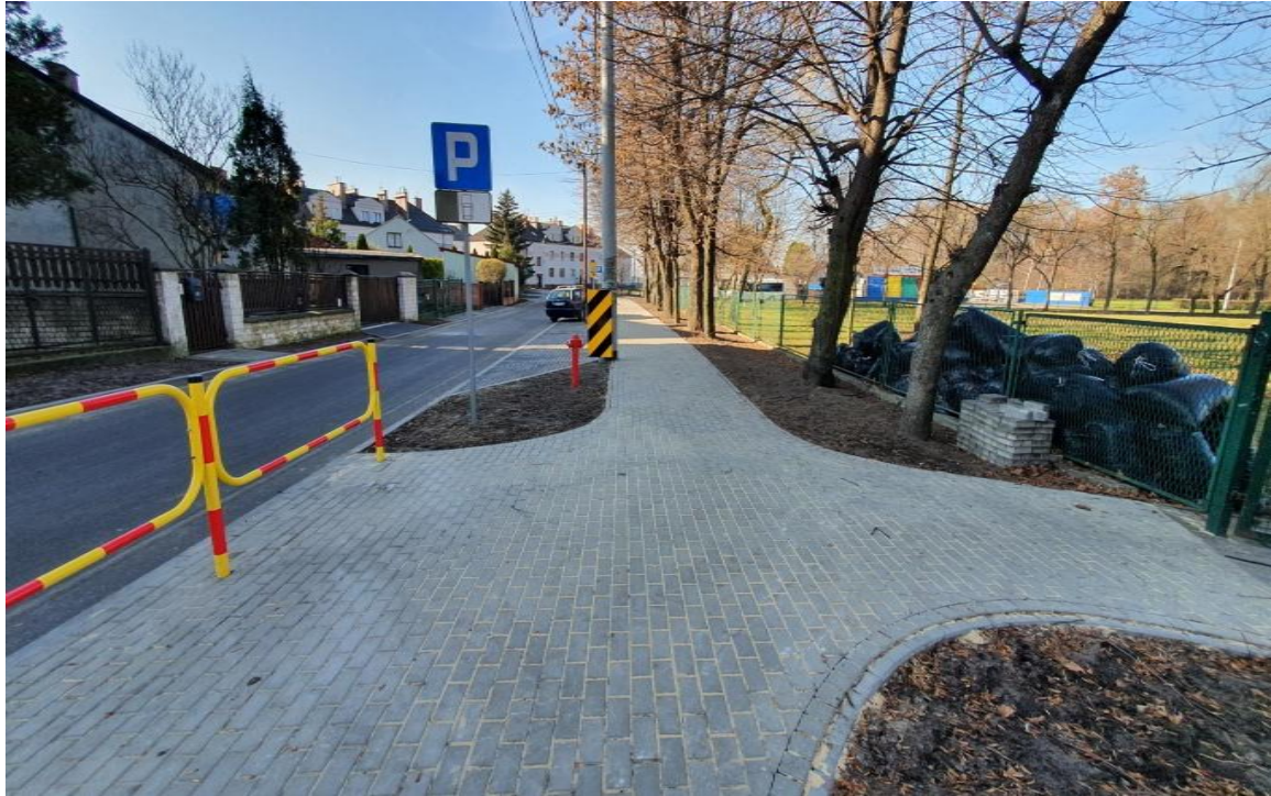
ul. Szkolna – po przebudowie
