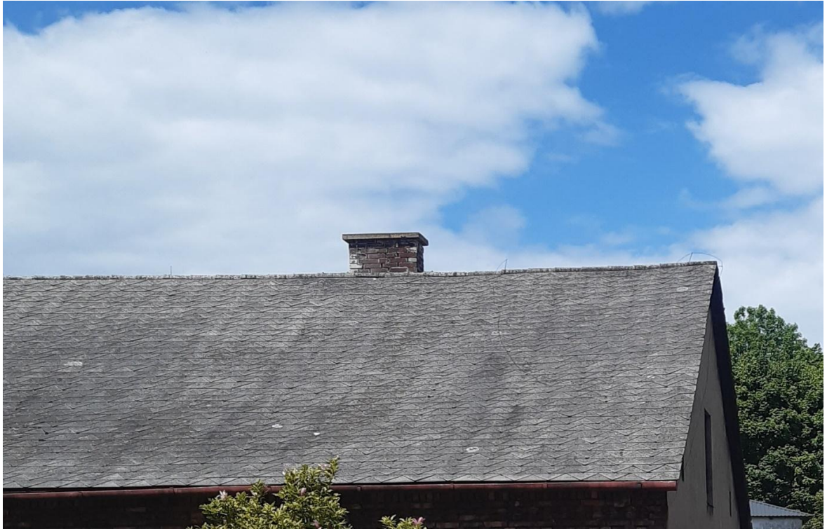
Pokrycia dachowe z azbestu
