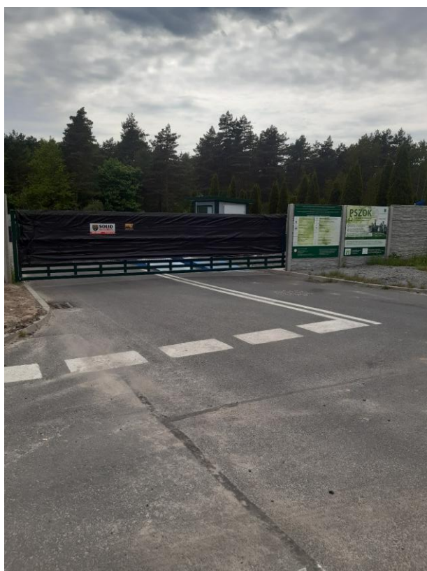
Punkt Selektywnego Zbierania Odpadów Komunalnych w Ogrodzieńcu
