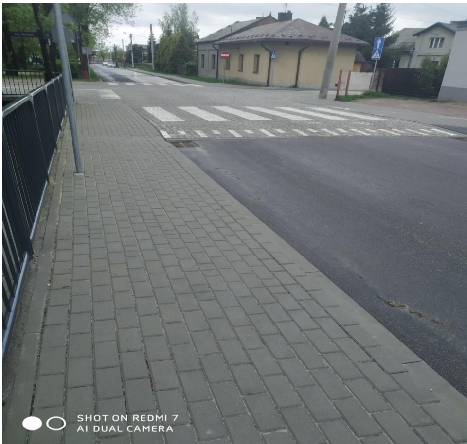
ul. Mostowa po przebudowie
