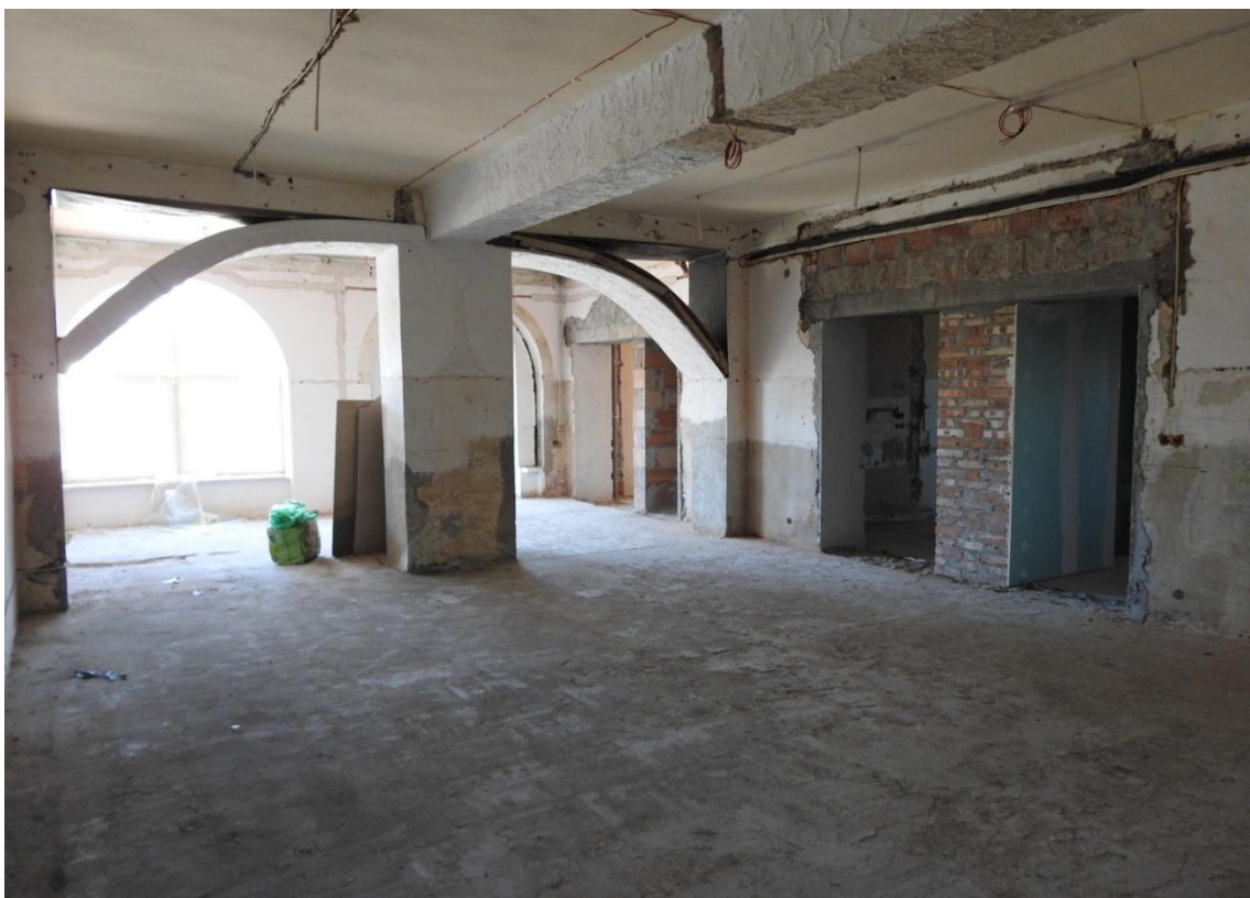
Stan przed remontem
