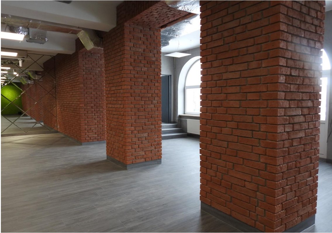
Tak wyglądają pomieszczenia na parterze MGOKiS po pierwszym roku remontu
