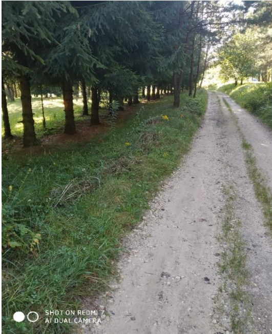
Stan przed przebudową
