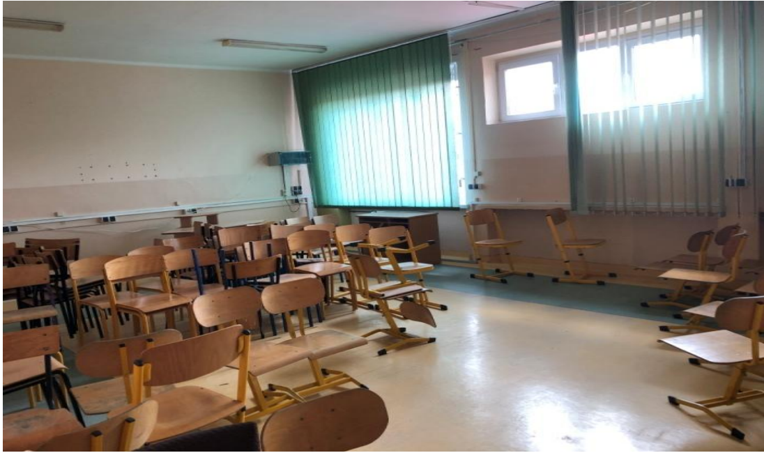
Stan przed remontem
