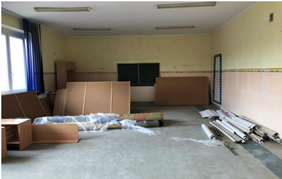
Stan przed remontem
