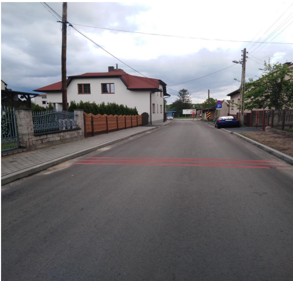
ul. Kopernika po przebudowie
