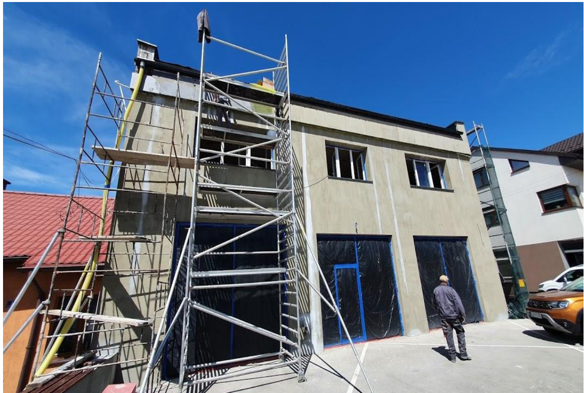
W trakcie remontu
