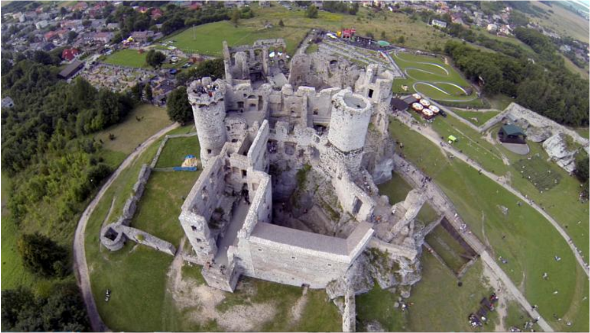
Ruiny Zamku Ogrodzienieckiego z lotu ptaka
