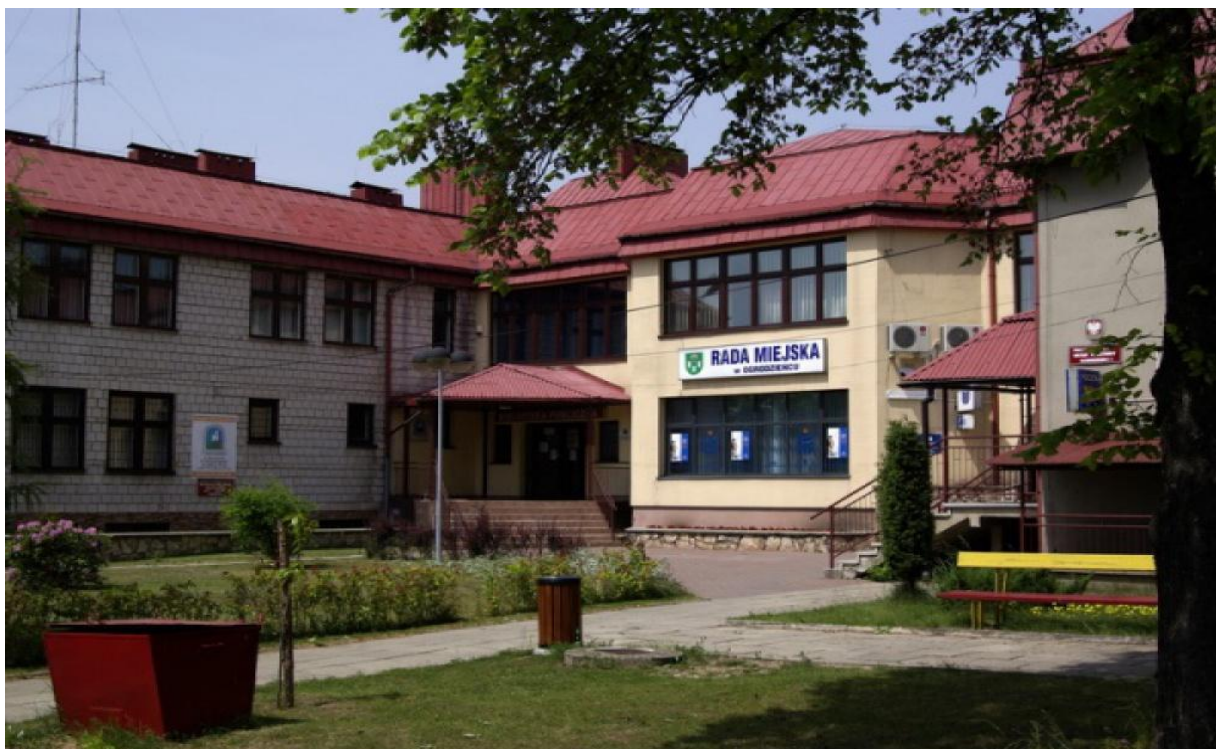
Stan obiektu przed remontem
