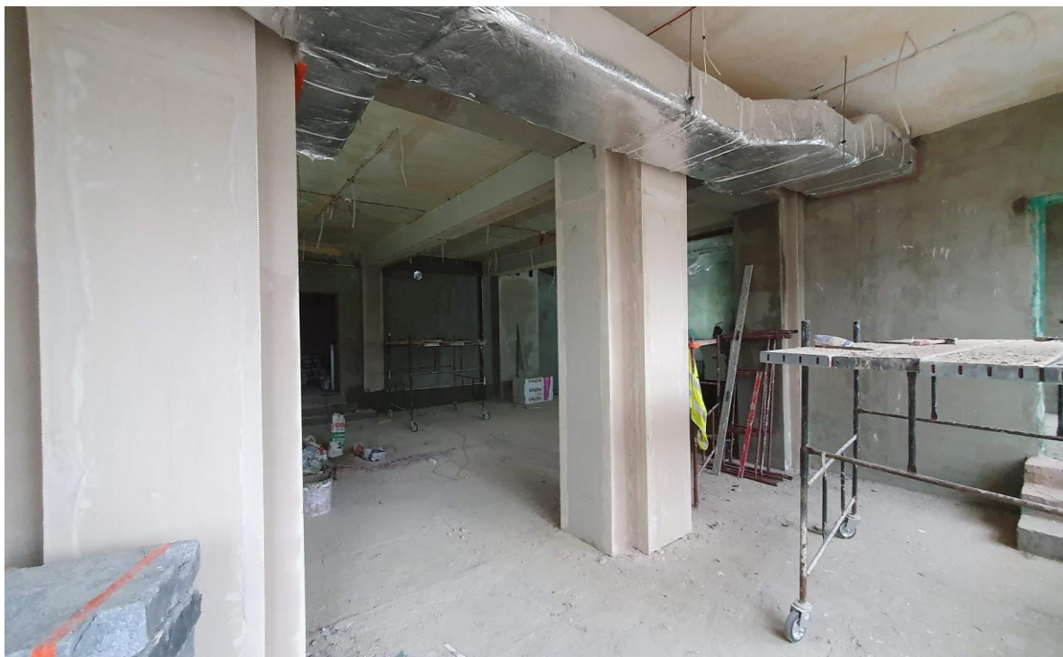
Stan w trakcie remontu
