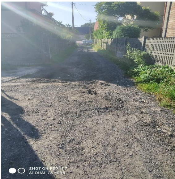
Stan przed przebudową
