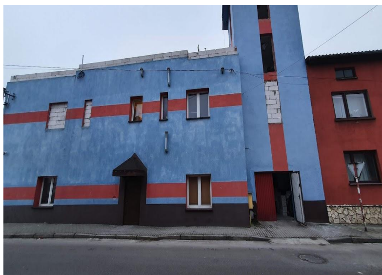
Stan przed remontem
