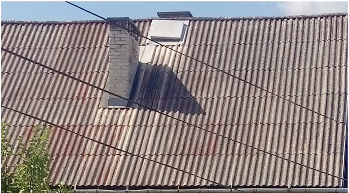
Pokrycia dachowe z azbestu
