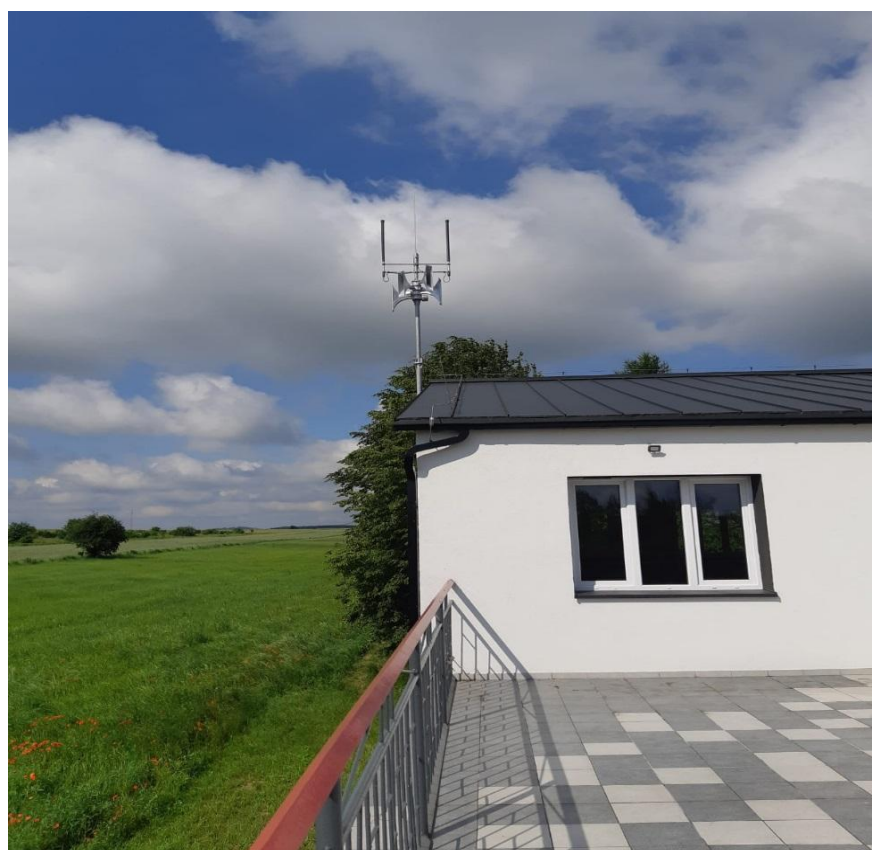
Remiza OSP Gulzów w której zainstalowano nowy system ostrzegania i alarmowania
