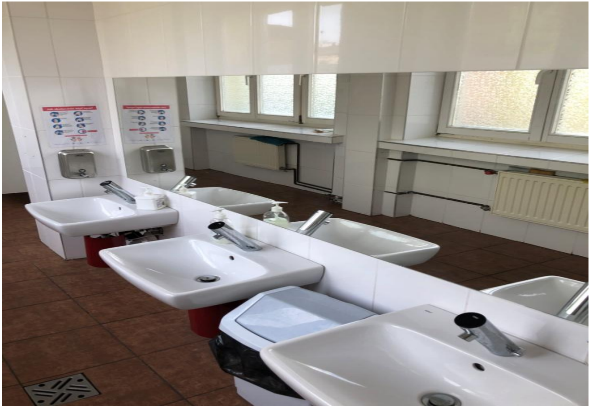
Stan po remoncie
