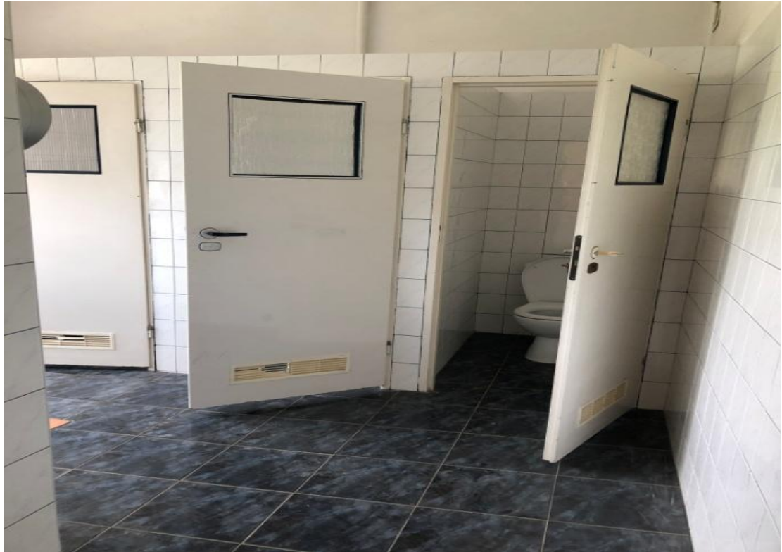
Stan przed remontem
