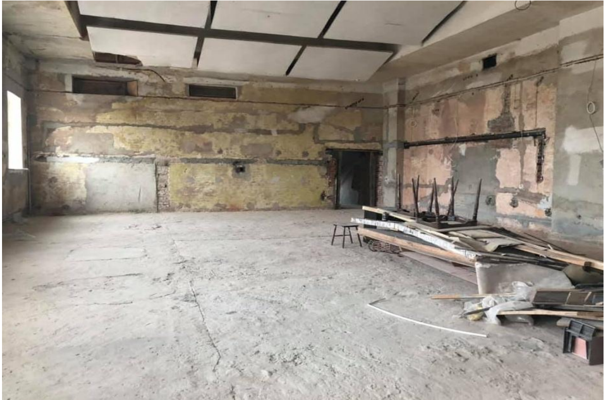
Stan w trakcie remontu
