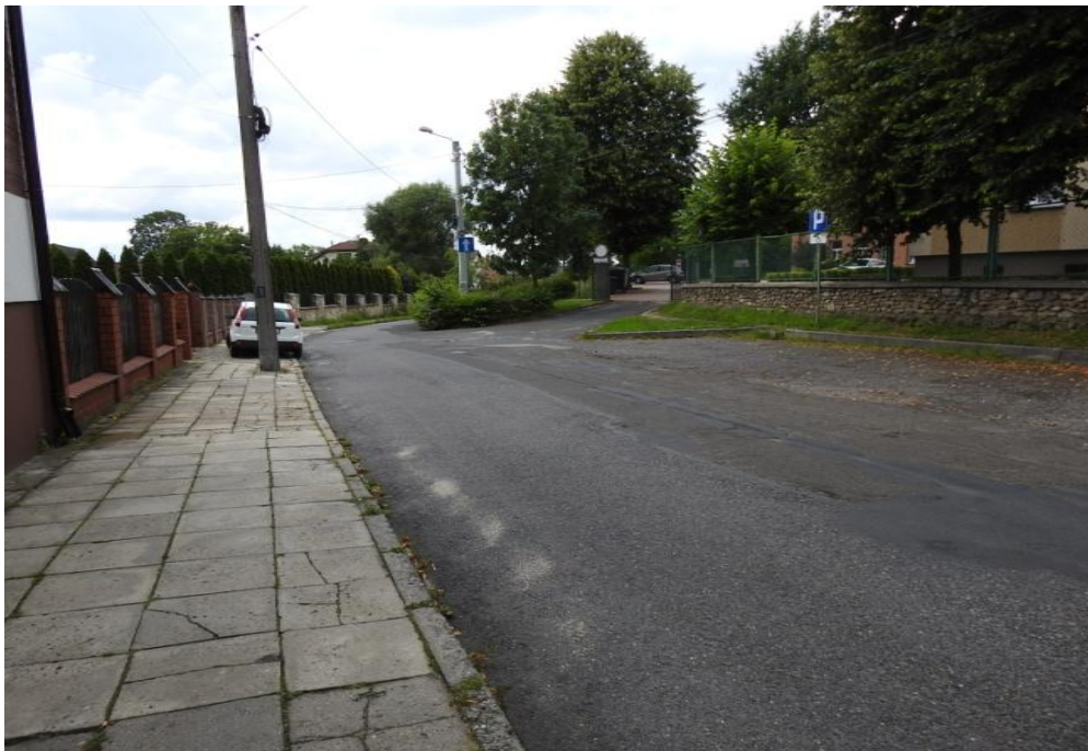
ul. Szkolna – przed przebudową
