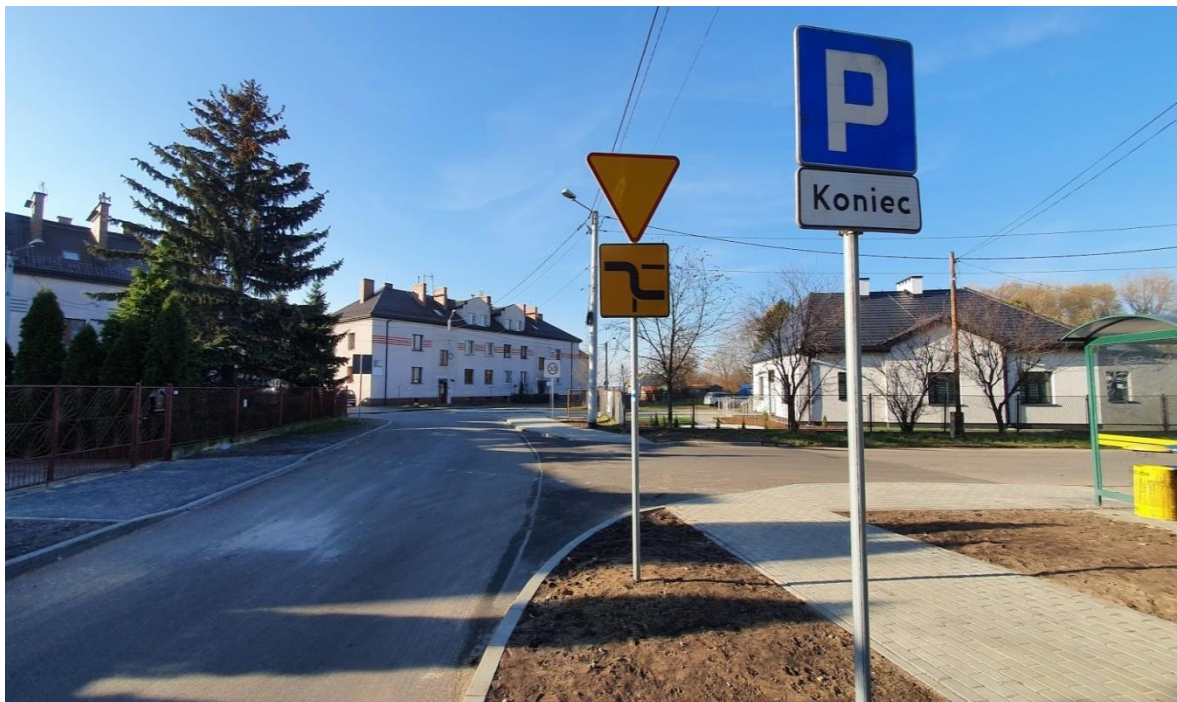
ul. Szkolna – po przebudowie
