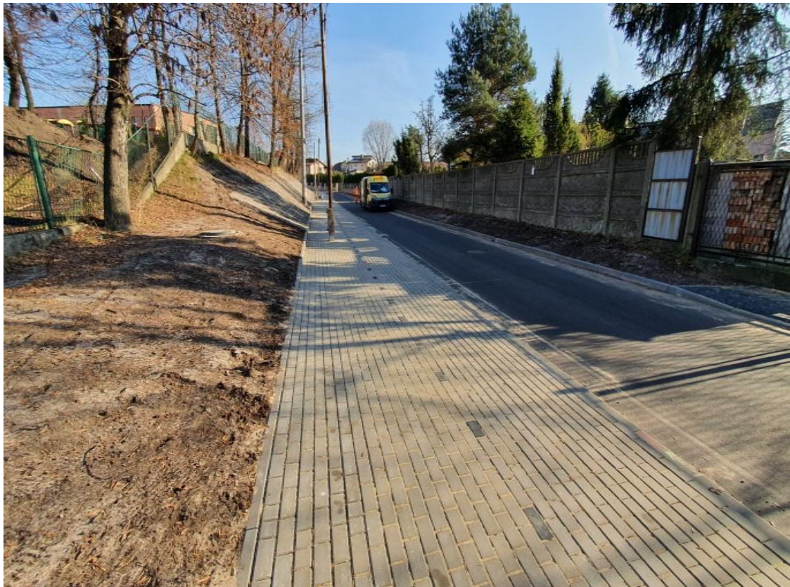
ul. Szkolna – po przebudowie
