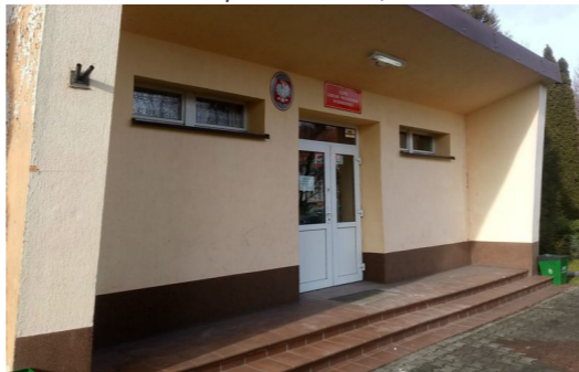
A ISTNIEJĄCE WEJŚCIE DO BUDYNKU DO LIKWIDACJI SCHODY ZEWNĘTRZNE I SPOCZNIK WYKONANY JAKO BETONOWY WYKOŃCZONY PŁYTKAMI ZEWNĘTRZNYMI PRZEZNACZONE DO LIKWIDACJI powierzchnia: 13,50m 2
