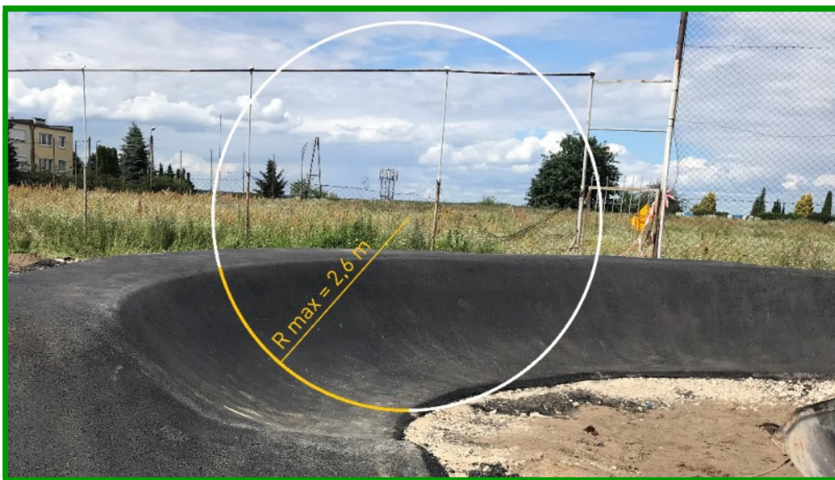
Prawidłowo wykonany zakręt profilowany, którego przekrój stanowi wycinek koła.
