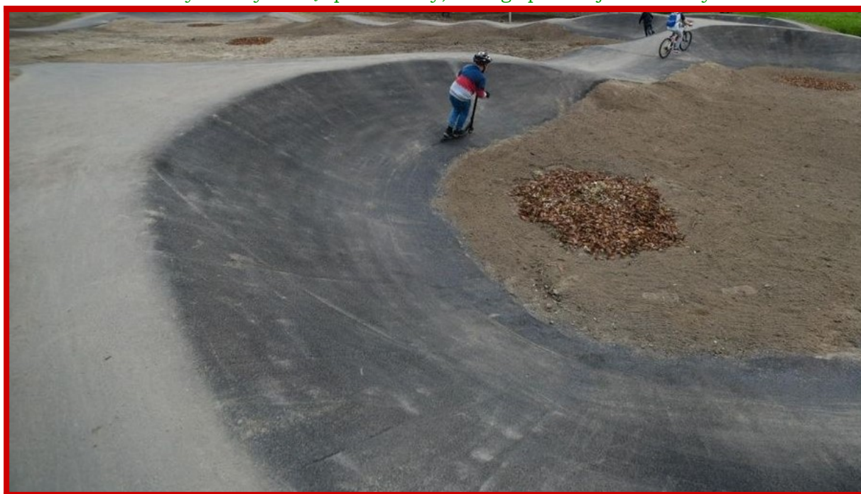
Nieprawidłowo wykonany zakręt o niejednostajnym promieniu, bez wypłaszczonej dolnej półki oraz niebędący w przekroju wycinkiem koła.
